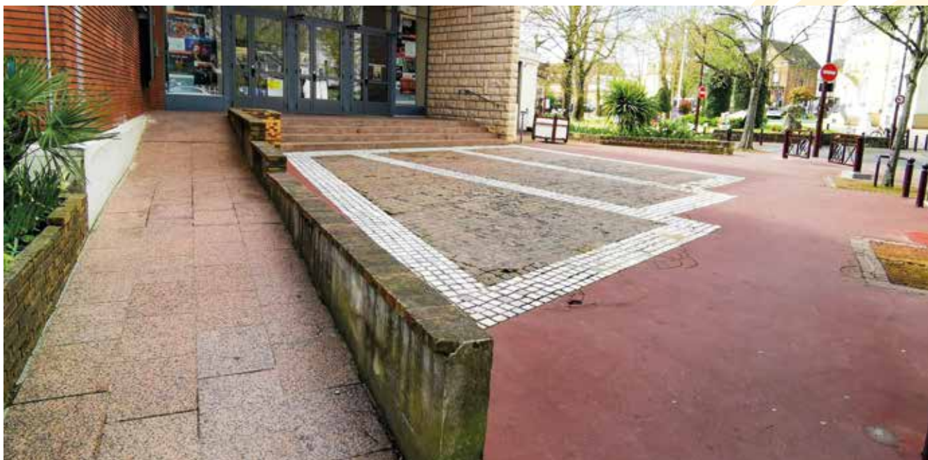
Rampe d'accès à la salle Georges Brassens
