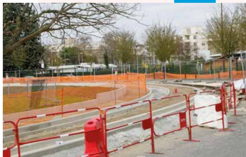
Réfection de la rue Entroncamento
