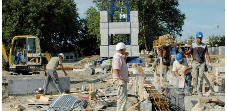
Le chantier de l'école Charles Péguy.
