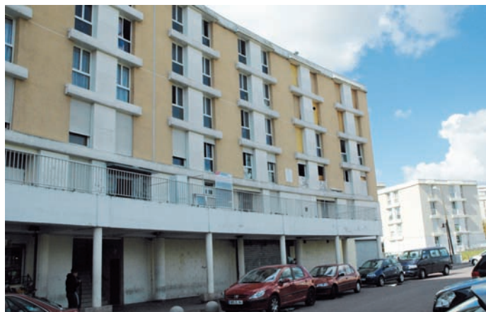
Le bâtiment Bécaud promis à la démolition.
