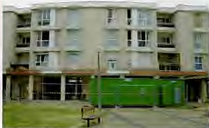
Place Paul Valéry : démolition de 14 logements, pour pouvoir faire passer la nouvelle voie.
