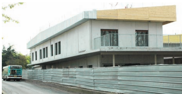
Vue d'ensemble de la nouvelle école Péguy depuis le boulevard Bishop's Stortford.
