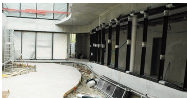
Dans le patio intérieur : les futurs espaces végétalisés et le jardin pédagogique.
