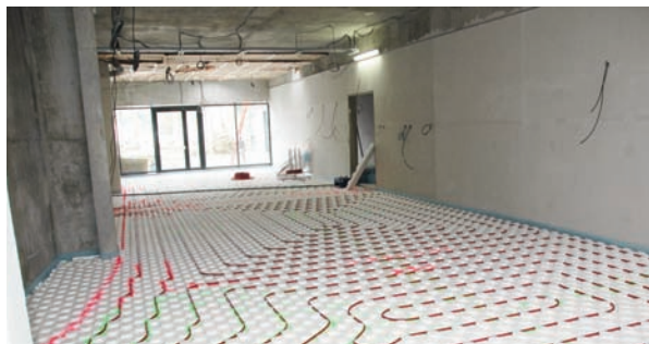
Mise en place du plancher chauffant, dans la future salle de motricité (120 m 2 ).
